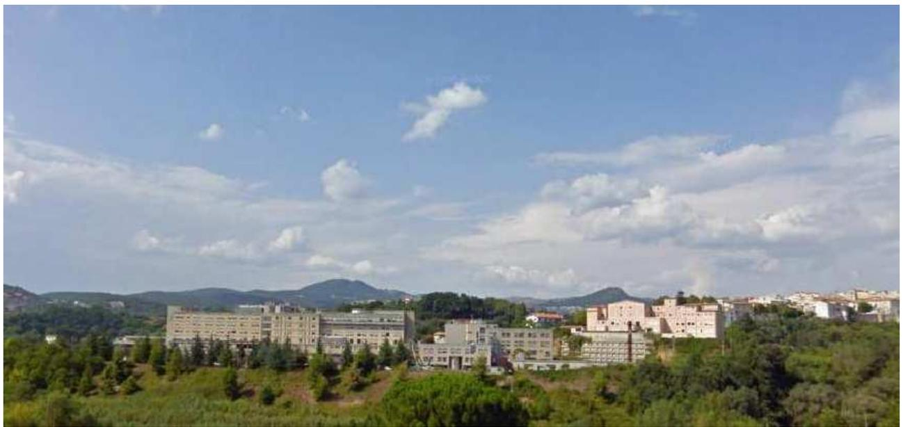
L'opera, progettata intorno alla fine degli anni '60, è stata realizzata tra gli anni '70 e '80, con struttura in calcestruzzo armato e con orizzontamenti in latero-cemento.
