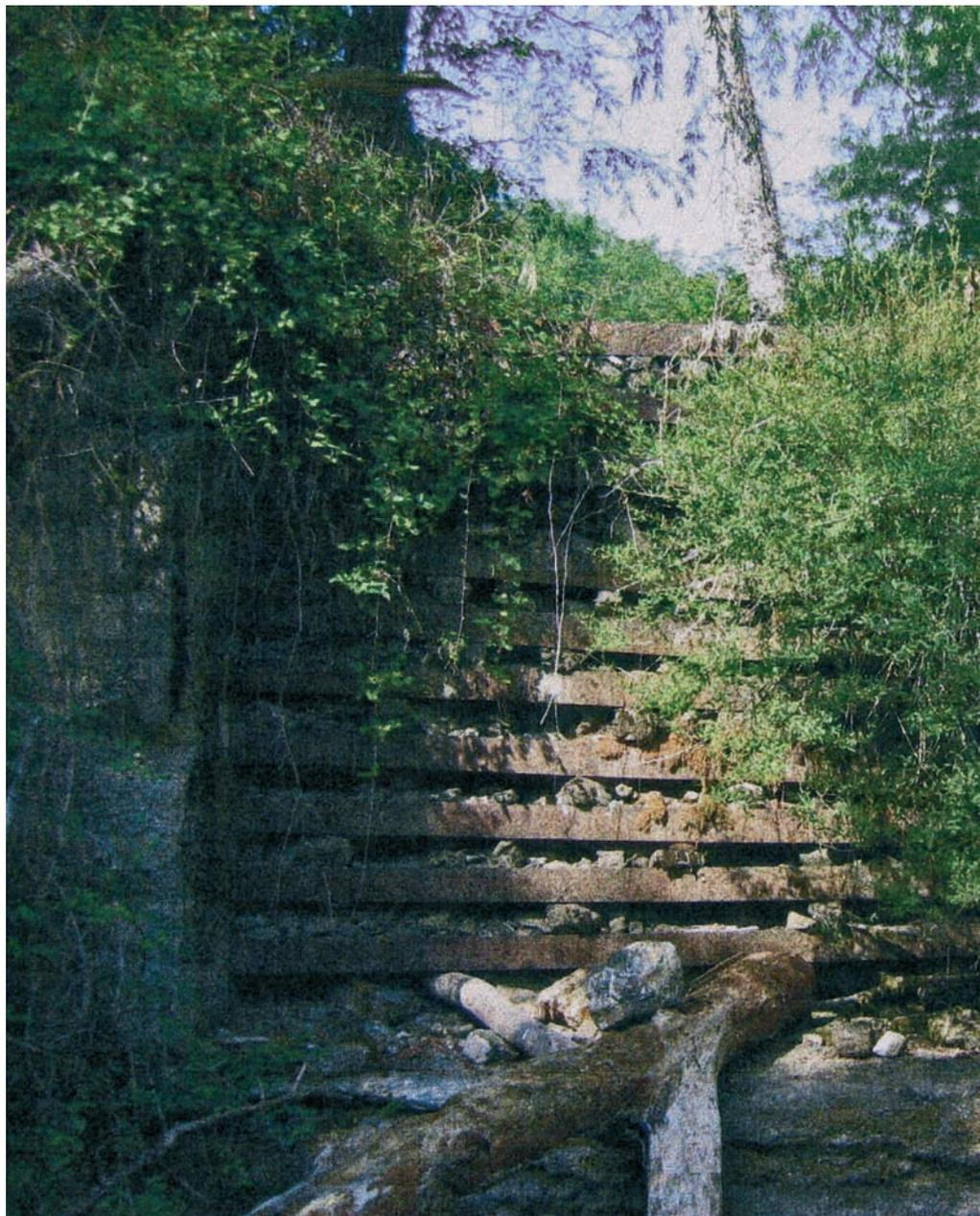
*Foto 1.3.10: Briglia filtrante nel Vallone dell'Inferno ad Anzi (PZ) costruita nel 1966. Si noti l'interrimento selettivo e il ricoprimento con vegetazione spontanea del paramento grigliato a valle formato da putrelle d'acciaio. Alternativamente sono state impiegate rotaie ferroviarie usate - Foto C. Zaccone*
