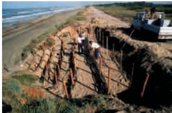
Foto 5.8.3: Fasi della realizzazione del consolidamento combinato
