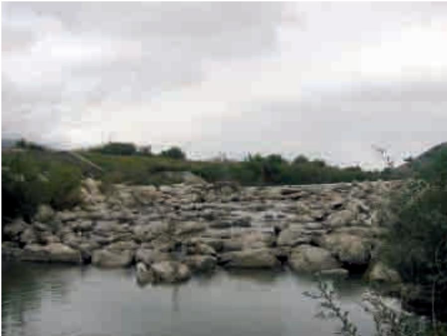
*Foto 5.1.5: Rinaturazione di briglia in cemento con rampa a blocchi sul F. Tanagro (ottobre 2003) - Foto P. Cornelini*
