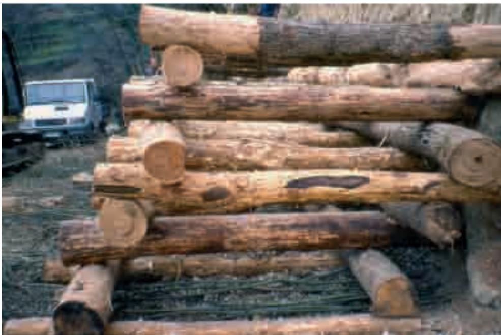
*Foto 1: Struttura di una palificata viva doppia di consolidamento del piede della frana 1 (marzo 2000) - Foto P. Cornelini*
