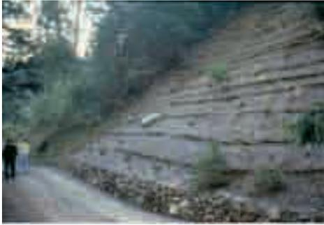
*Foto 5.2.3: Sistemi stabilizzanti su scarpata in detrito di falda Loc. Pussa (PN) - Foto G. Sauli*
