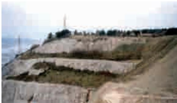
*Foto 5.6.3: Ritombamento parziale con inerti di riciclaggio e rivegetazione di scarpate su cava a gradoni Cava Scoria (TS) - Foto G. Sauli*
