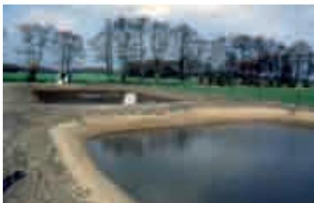
*Foto 5.4.18: Ecosistemi filtro con funzione di vasche di prima pioggia in costruzione a lato strada (Brema-D) - Foto G. Sauli*
