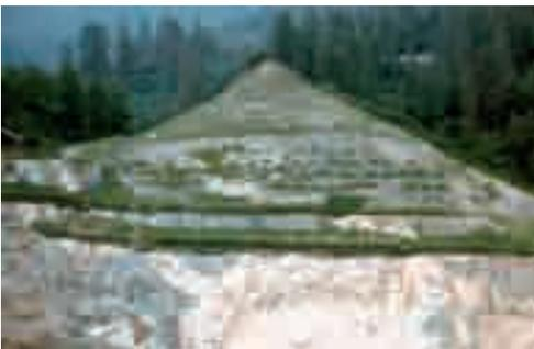
*Foto 5.5.8: Realizzazione di materassi a sacche in rete metallica e stuoia sintetica tridimensionale riempite di terreno e rivegetate Miniera di Giustino Val Rendena (TN), visione d'insieme (1996) - Foto G. Sauli*
