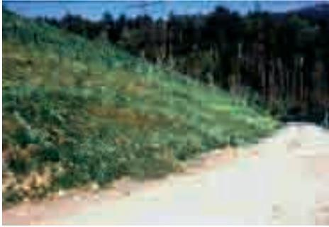
Foto 5.6.1: Rivegetazione mediante semine, messa a dimora di arbusti e gradonate vive di salice. Discarica RSU di versante di Sciaves (BZ) - Foto F. Palmeri
