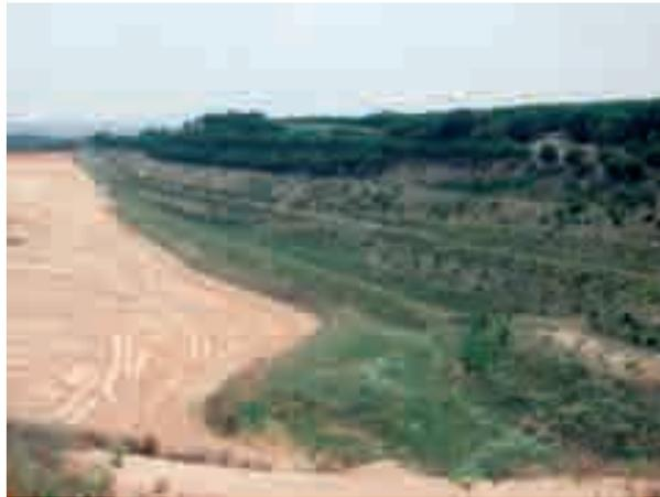
*Foto 1: situazione attuale - vista delle scarpate recuperate (la coltivazione prosegue nel piazzale di base)
