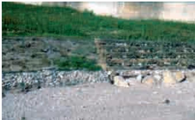
Foto 3: F. Fella presso la stazione FS di Valbruna. Visibili la copertura diffusa (sx) e le palificate spondali fondate su massi (dx) - Foto G. Sauli
