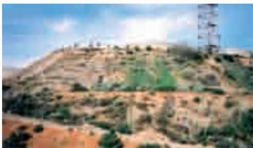
*Foto 5.6.6: Interventi sperimentali antierosivi e di stabilizzazione su scarpata di discarica mineraria a Campo Pisano (Iglesiente-Sardegna) a distanza di 7 anni (2002) - Foto G. Sauli*
