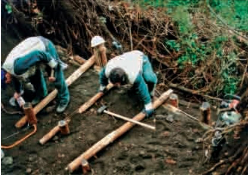
*Foto 1: Operai L.S.U. in fase di realizzazione di una palificata Vesuvio sec. Menegazzi (ottobre 1999) - Foto G. Menegazzi*
