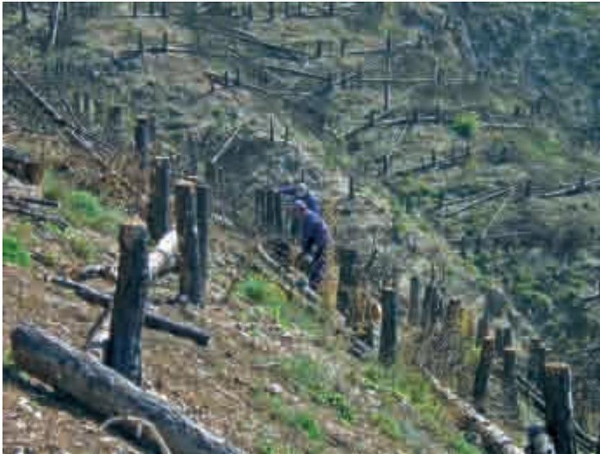
*Foto 1: Lavori di realizzazione delle palizzate morte (ottobre 2002) - Foto Sacchetti Liberatore*
