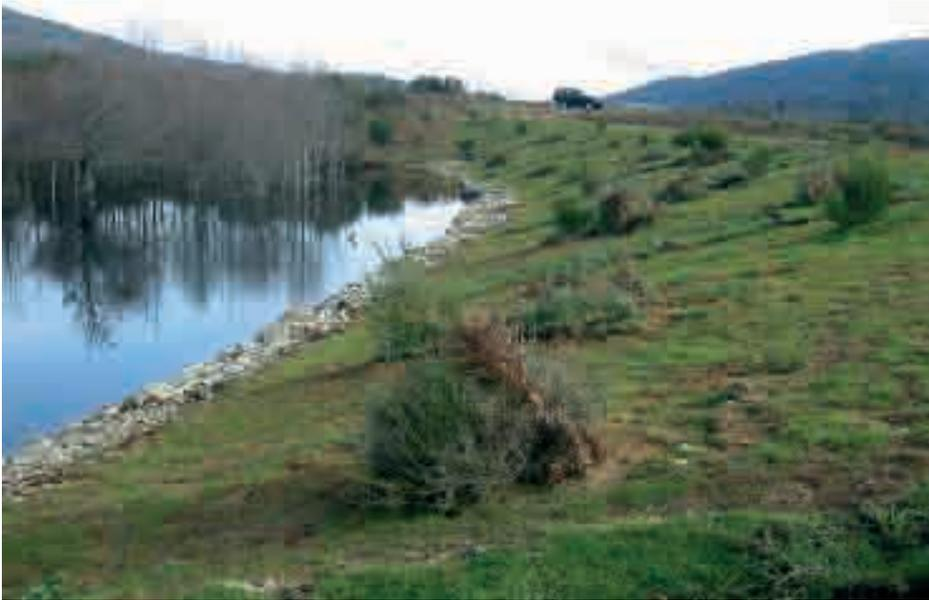
*Foto 3: Rinaturalizzazione del paramento di un argine con trapianti di zolle ed ecocelle (giugno 2002) - Foto P. Cornelini*
