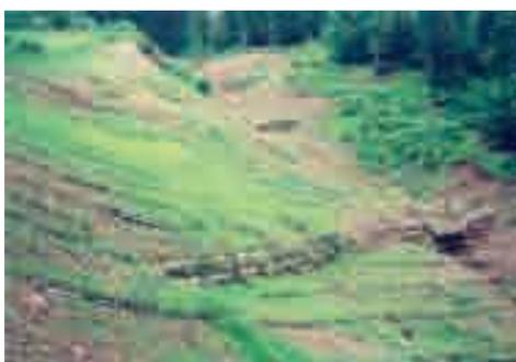
*Foto 5.2.15: Sistemi di consolidamento e stabilizzazione di impluvi montani mediante briglie in legname e pietrame e cordonate vive Ligosullo (UD) - Foto G. Sauli*
