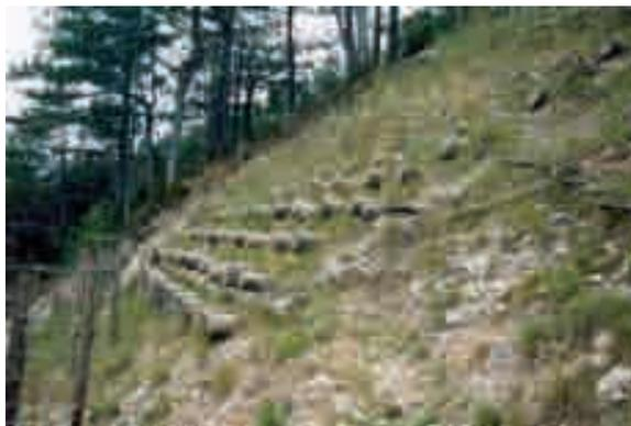
*Foto 3: Metanodotto Malborghetto - Bordano. Consolidamento del versante con palificate vive. Loc. Chiaranda (Val Aupa - UD) - 2003 Foto G. Sauli*
