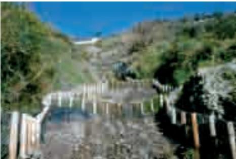
*Foto 5.2.12: Graticciate in micropali cor-ten, reti metalliche e stuoie tridimensionali per consolidamento impluvi in rocce friabili T. Giarina (ME) - Foto G. Sauli*
