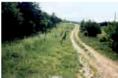
*Foto 5.7.4: Rivegetazione su tracciato di metanodotto (Carso triestino) mediante semine con fiorume e messa a dimora di arbusti autoctoni con reticelle di protezione faunistica - Foto G. Sauli*
