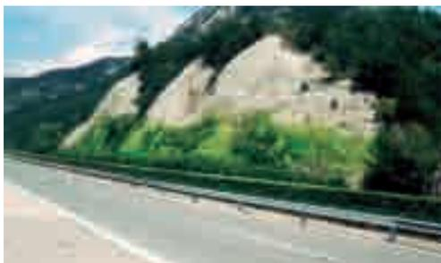
*Foto 5.4.12: Scarpata con spritz beton con rampicanti S. Simeone (UD) - Foto G. Sauli*
