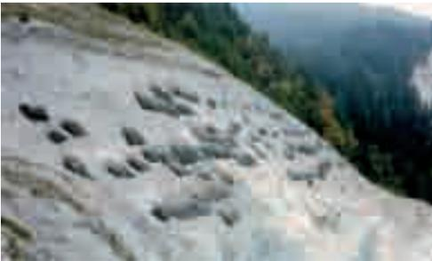
*Foto 5.5.7: Realizzazione di materassi a sacche in rete metallica e stuoia sintetica tridimensionale riempite di terreno e rivegetate, Miniera di Giustino Val Rendena (TN) - Foto G. Sauli*
