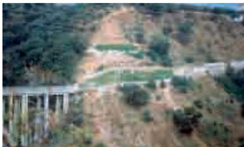
*Foto 5.4.11: Muri cellulari rinverditi su scarpata in scavo (CZ) - Foto G. Sauli*
