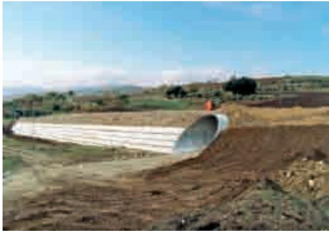
*Foto 1: Uno dei primi rilevati stradali in doppia terra rinforzata realizzati in Italia Loc. Blufi 1988 - Foto Harpo SEIC*
