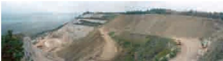
*Foto 5.6.4: Ritombamento parziale con inerti di riciclaggio e rivegetazione di scarpate su cava a gradoni Cava Scoria (TS) - Foto G. Sauli*
