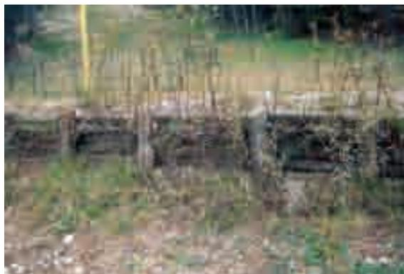
*Foto 1: Metanodotto Malborghetto - Bordano. Palizzate vive, palificate vive, Loc. Chiaranda (Val Aupa - UD) 2003 - Foto G. Sauli*
