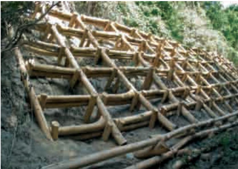
*Foto 2: Palificata doppia con grata Vesuvio sec. Menegazzi con arbusti radicati; fase di costruzione (luglio 2003) - Foto G. Menegazzi*
