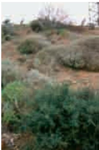
*Foto 5.6.7: Interventi sperimentali antierosivi e di stabilizzazione su scarpata di discarica mineraria a Campo Pisano (Iglesiente-Sardegna), particolare particella con impiego di soli arbusti autoctoni di gariga mediterranea dopo 7 anni dall'intervento - Foto G. Sauli*
