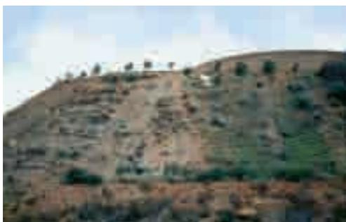
*Foto 5.6.5: Interventi sperimentali antierosivi e di stabilizzazione su scarpata di discarica mineraria a Campo Pisano (Iglesiente-Sardegna) a distanza di 5 anni (2000) - Foto G. Sauli*
