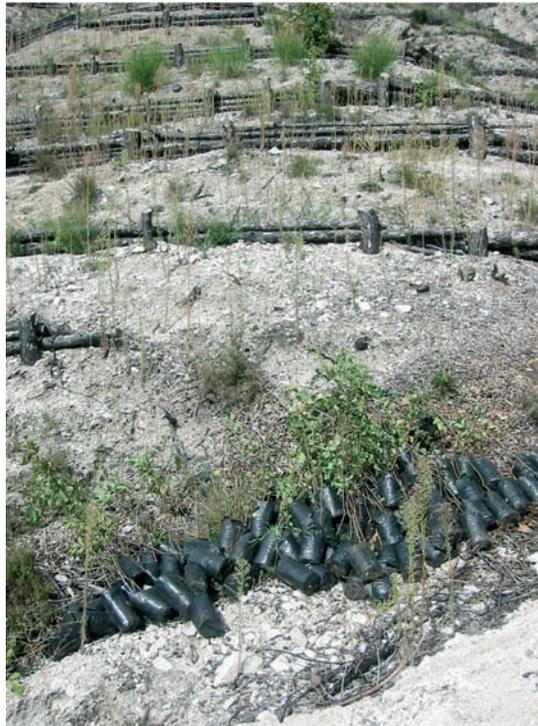
Foto 7.17: Palizzate vive in corso di realizzazione (ottobre 2003) Pizzoli (AQ) - Foto P. Cornolini
