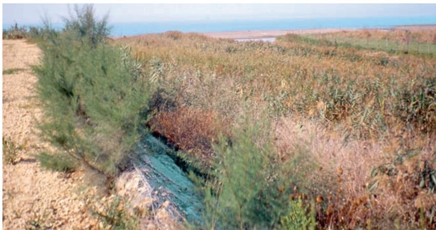
Foto 7.22: Materasso rinverdito con talee di tamerici (giugno 2001) T. Arrone (VT) - Foto P. Cornolini
