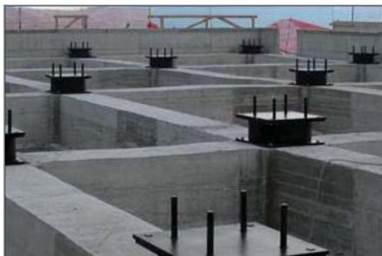
Figura 2. Isolatori elastomerici montati alla base della scuola nel comune di Morrone del Sannio (CB)
