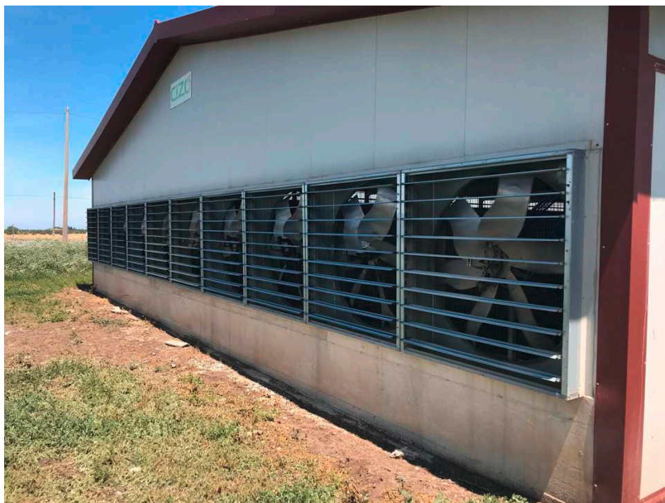
Figura 2 – Estrattori d'aria capannone tipo A1.
