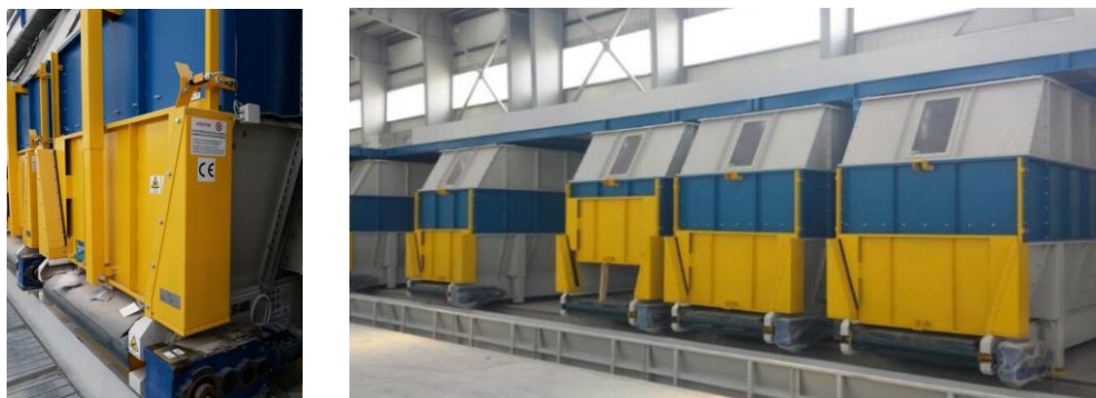
FIGURA 75: BOX DI STOCCAGGIO E DOSAGGIO, MODELLO BS 1.000 (ALTEN WASTE ENGINEERING SRL).
