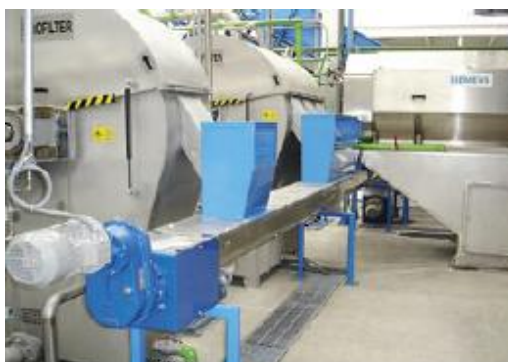
FIGURA 91: SISTEMA DI FILTRAZIONE MECCANICA DELLE ACQUE DI LAVAGGIO - ESEMPIO IMPIANTO REALIZZATO
