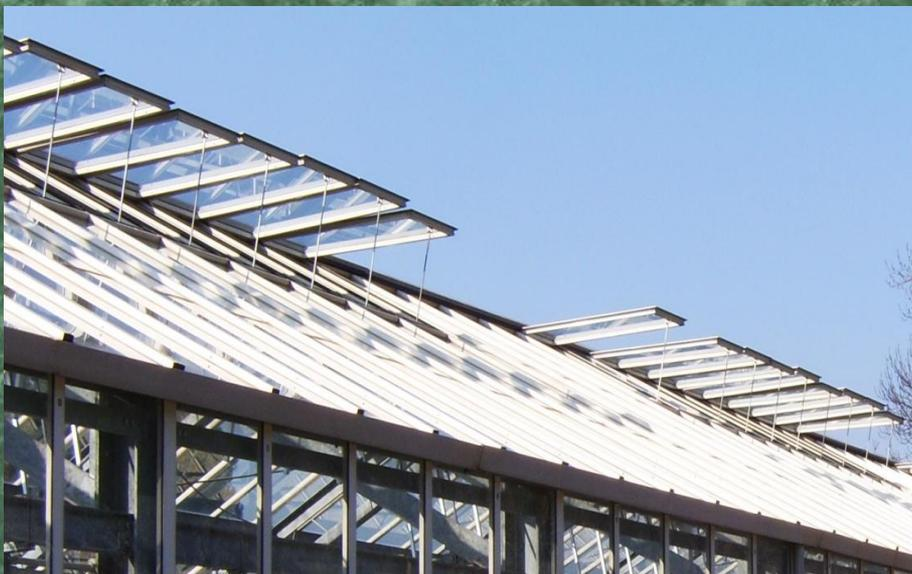
I lucernai sono muniti di un motore che ne regola l'apertura e la chiusura. Essi sono di fondamentale importanza per regolare la temperatura all'interno della serra.
