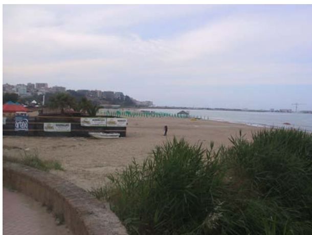
Litorale Sud - Veduta da Ponte Sei Voci - zona Rio vivo
