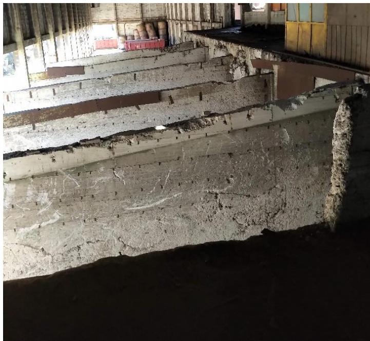
Figura 14: Dettaglio Edificio F, dove sarà prevista la demolizione dei setti verticali e del solaio, e la chiusura della parete est – FONDERGHISA, Pozzilli (IS).
