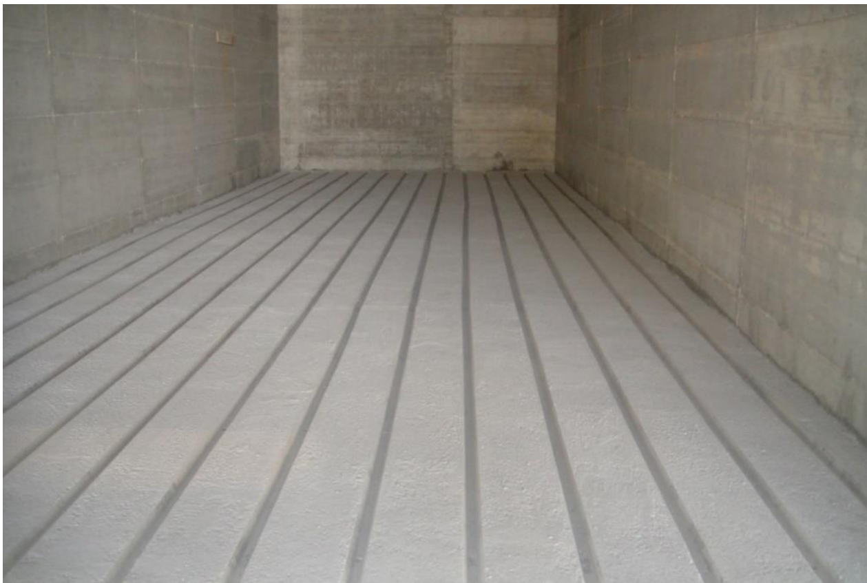
Figura 19: Esempio di sistema di aerazione posto sulla pavimentazione di una biocella [Smaltimenti Sud Srl]
