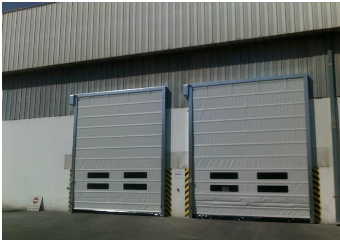
Figura 18: Esempio di portoni sezionali ad impacchettamento rapido per la zona di ricezione del VERDE.
