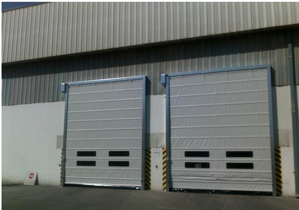
Figura 21: Esempio di portoni sezionali ad impacchettamento rapido per la zona di ricezione della FORSU
