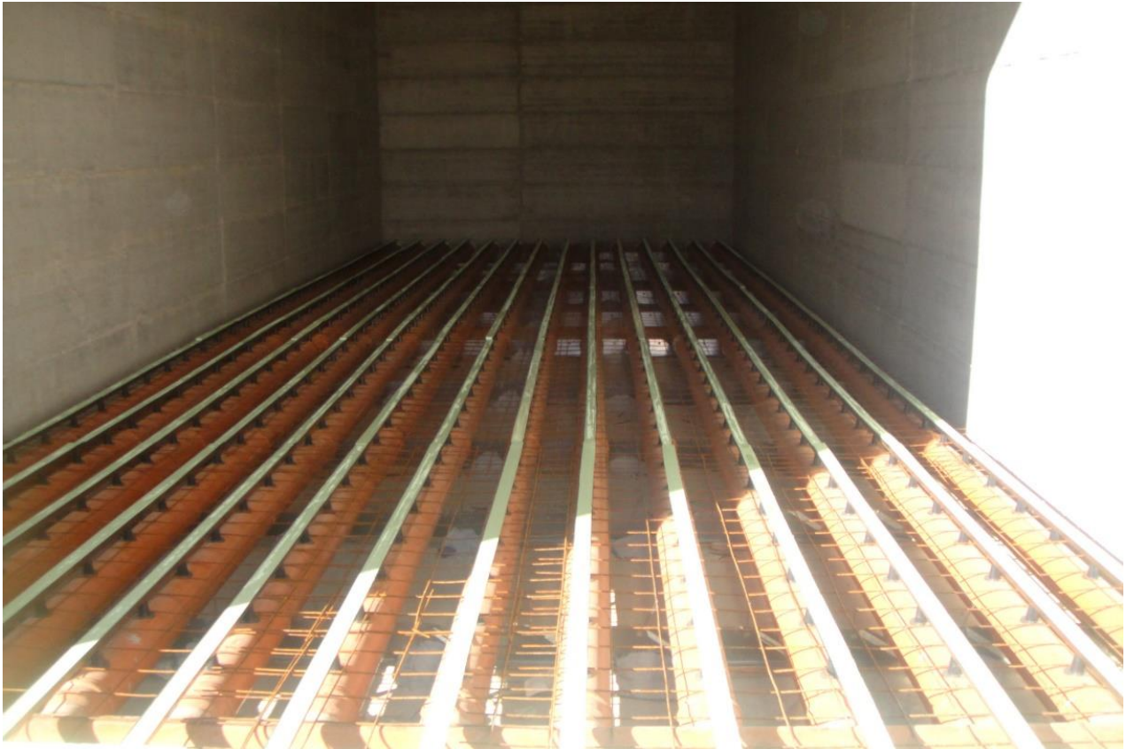
Figura 20 Esempio di fondazione pavimentazione aerata interna alle biocelle [Smaltimenti Sud Srl]
