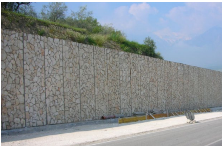
Fig.33 – Esempio di pannelli prefabbricati di rivestimento delle opere di sostegno
