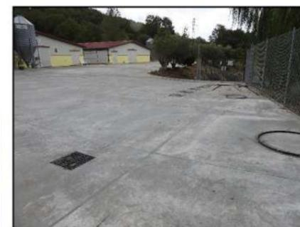
Il sistema idraulico di raccolta e smaltimento delle acque meteoriche prevede il convogliamento delle acque piovane tramite opportuni dispositivi: (griglie, caditoie...) dalle superfici esposte alle condutture di adduzione ai corpi recettori.
