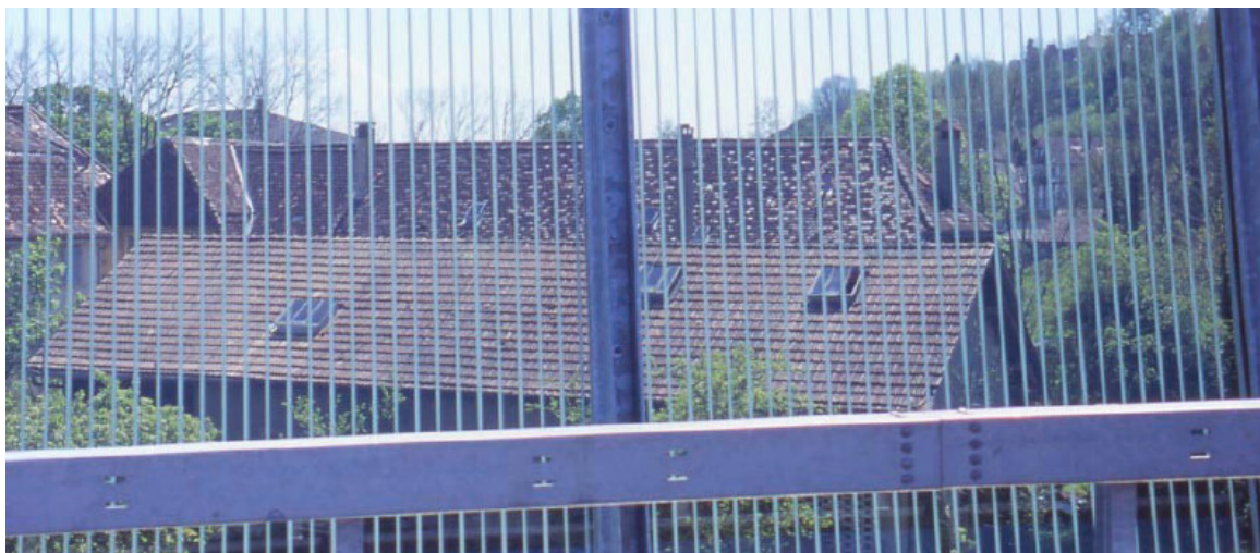
Figura 3-5 Esempio di pattern applicato ai pannelli trasparenti delle barriere antirumore
