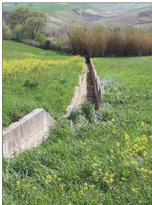
Figura 116: Canale con alveo cementato all'interno dell'area in studio.
