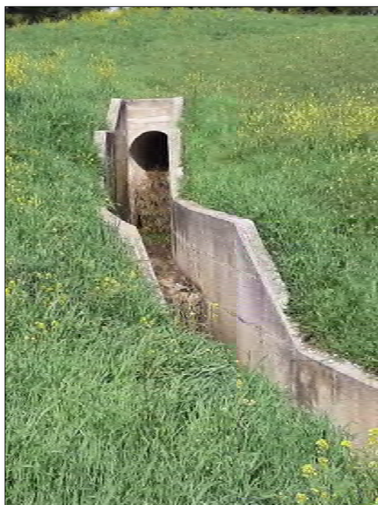
Figura 116: Canale con alveo cementato all'interno dell'area in studio.
