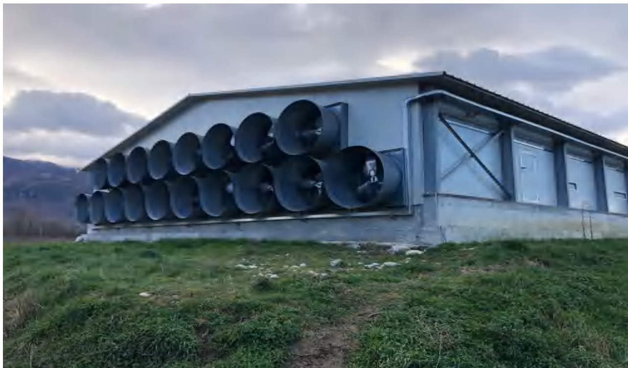
Foto 6 - Ventole di estrazione aria del capannone n. 3.
