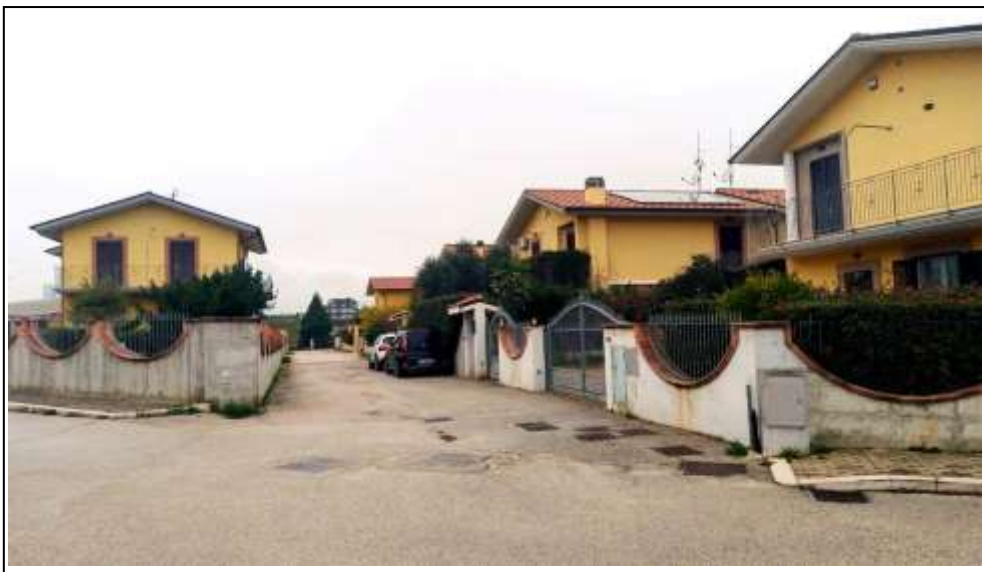
Foto 1 - Tratto di strada in progetto A-B visto da A
