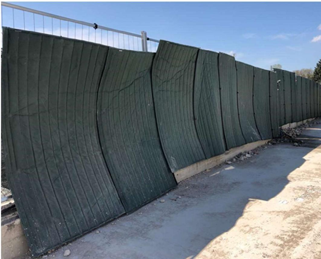
Foto 2. - Pannelli fono assorbenti installati a confine con la ditta Laborvetro.
