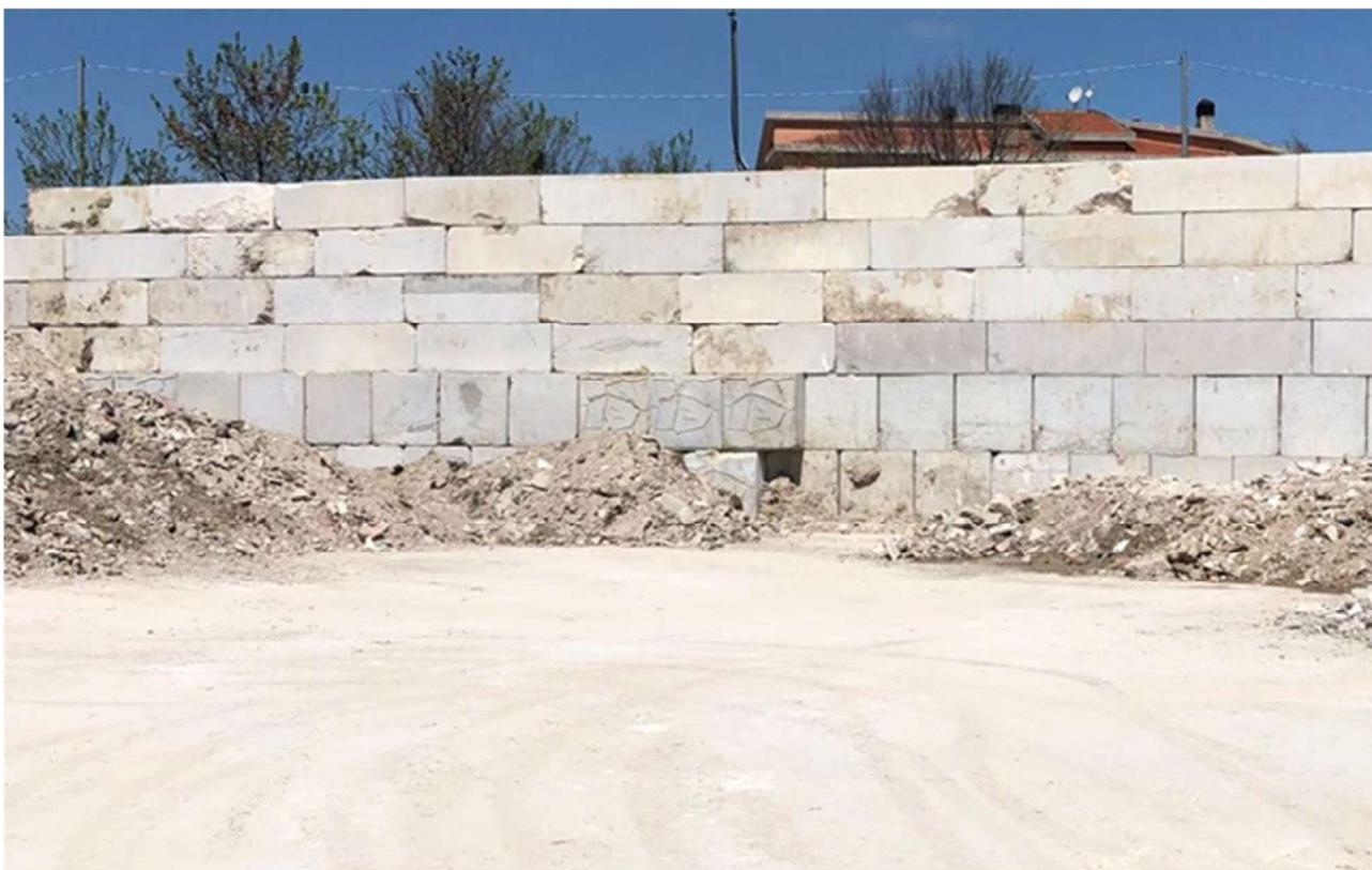
Foto 3. – Struttura avente funzione di barriera acustica installata a protezione della civile abitazione.
