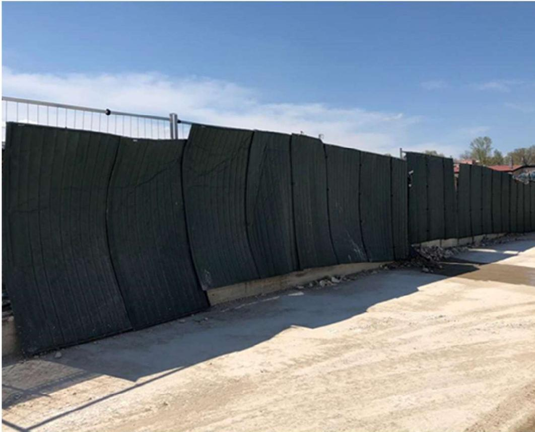
Foto 1. - Pannelli fono assorbenti installati a confine con la ditta Laborvetro.
