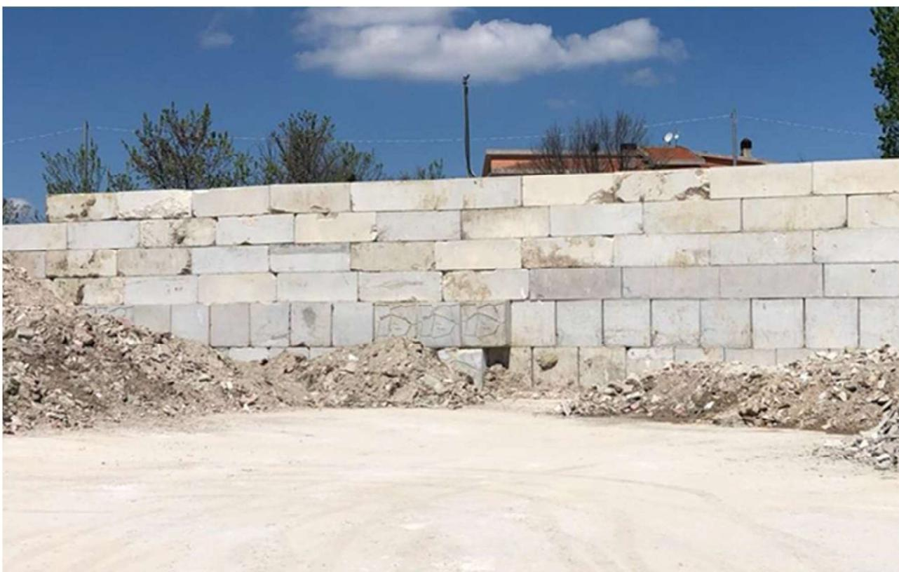
Foto 4. – Struttura avente funzione di barriera acustica installata a protezione della civile abitazione.
