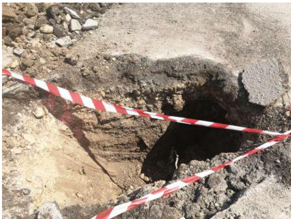
Particolare dello scavo di preforo: rilevabile la natura sabbio-limo-argillosa del sottosuolo.
